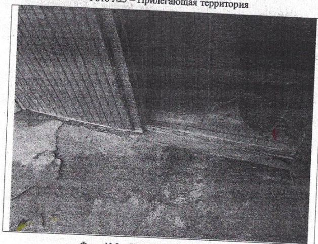
Фото №5 – Наружная входная дверь
